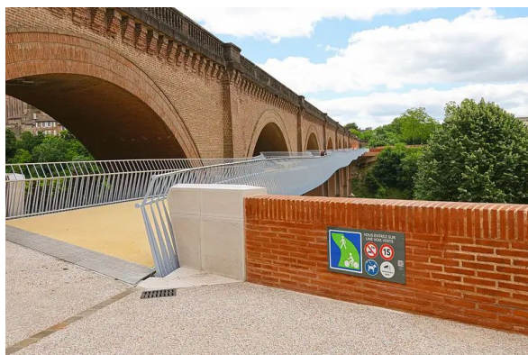
Figure n°20 : passerelle piétonne sur la rivière Tarn
