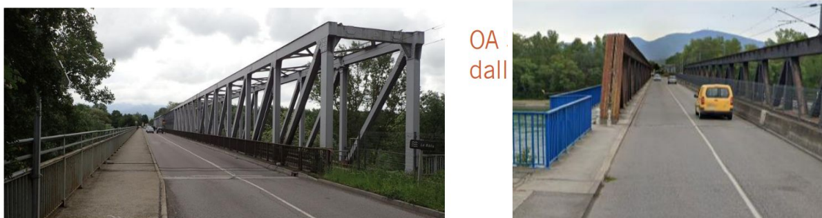
Figure n°22 : élargissement à Chalampé
